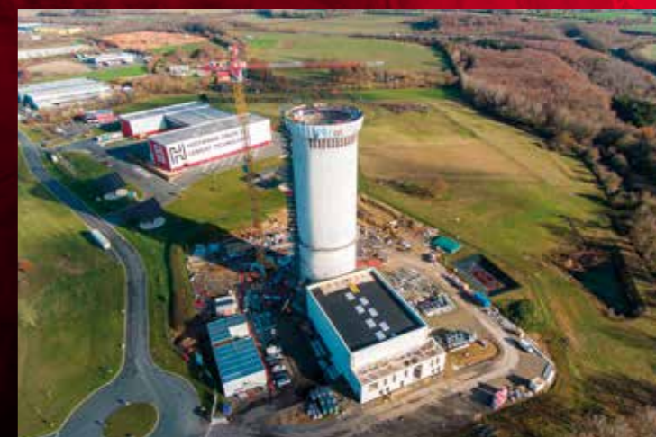
Décembre 2021 > Finalisation de la tour de production
