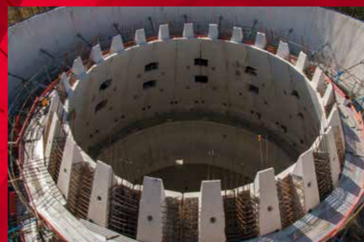
Septembre 2021 > Coulage du plancher
