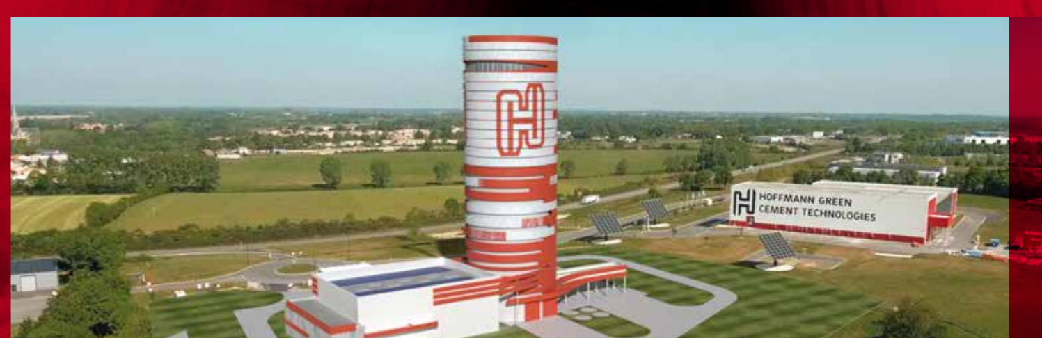
Vue finale de l'installation H2
