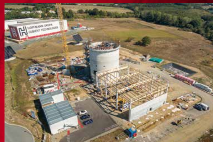
Septembre 2021 > Construction de la zone de stockage
