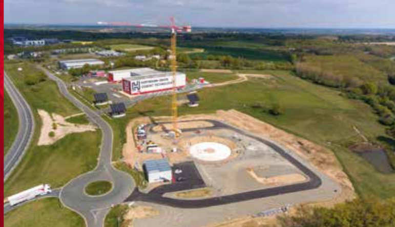
Mars 2021 > Coulage béton de propreté
