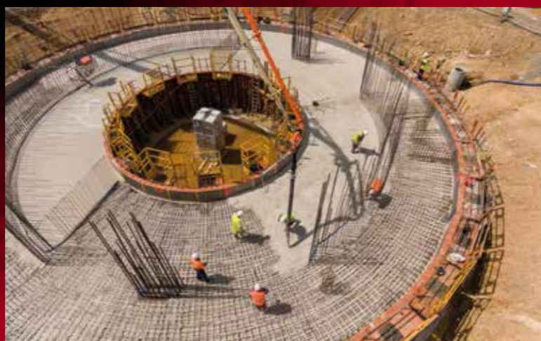
Mai 2021 > Coulage béton fondations
