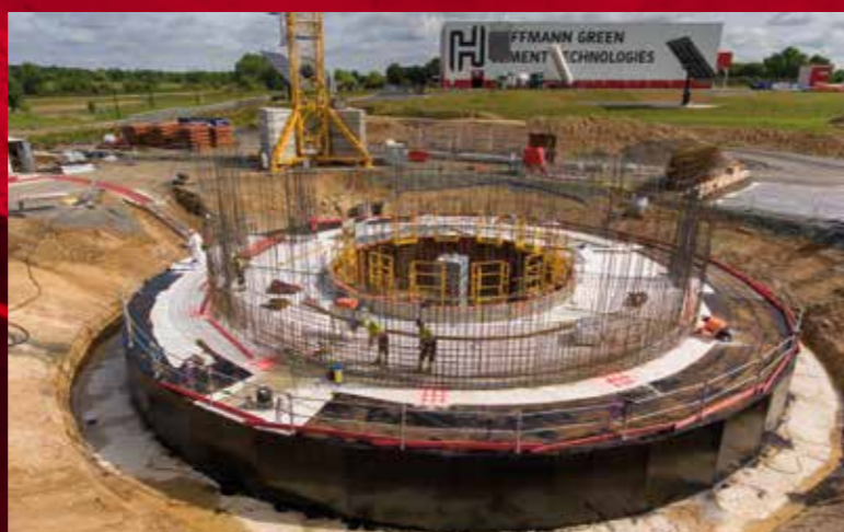
Mai 2021 > Décoffrage fondations
