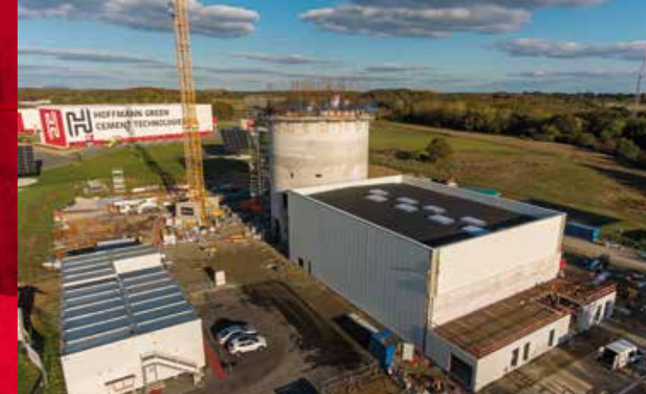
Octobre 2021 > Construction zone de stockage
