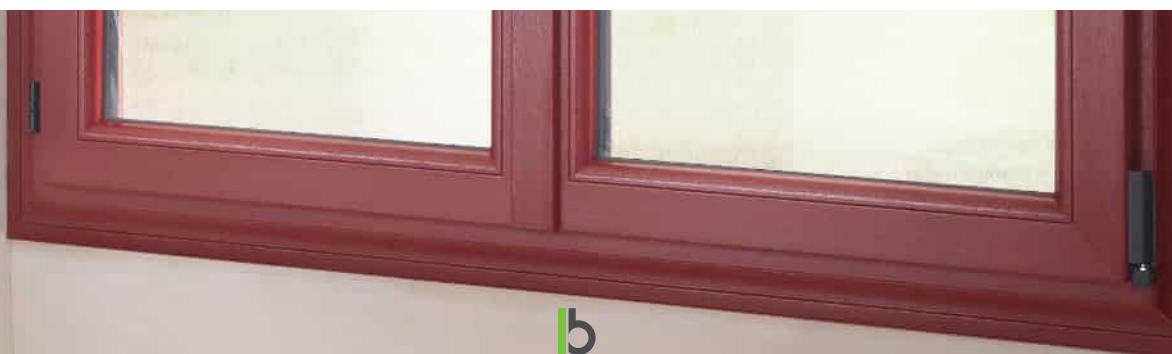
Paumelle standard à gauche et paumelle oscillo-battante à droite
