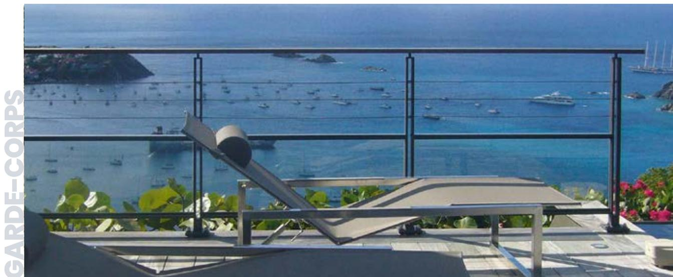
**BARREAUDÉE** - sous main-courante et portillon. Pose sur dalle, RAL 9016.
