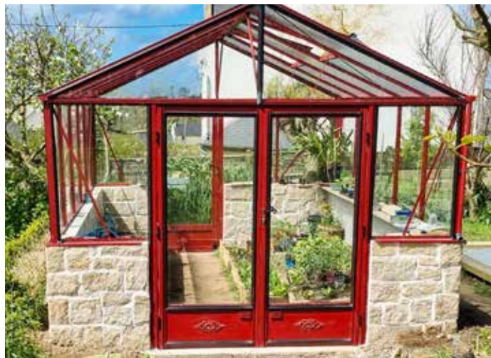
Porte double battante 2 x 0,77 m sur muret
