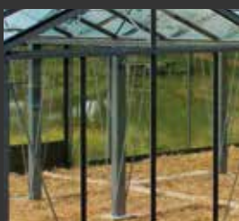
Poteaux intermédiaires fixés sur des plots en béton
