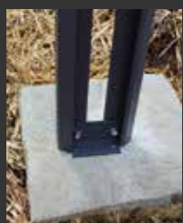
Poteaux intermédiaires fixés sur des plots en béton
