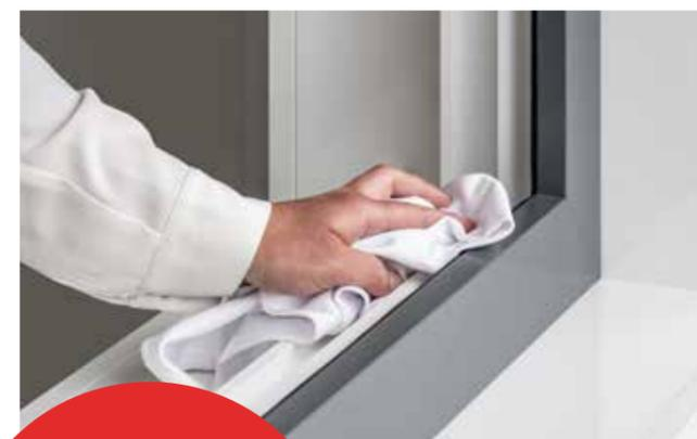
**Feuillure totalement lisse (sans gâches) pour un nettoyage aisé et un aspect épuré**
