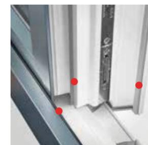
**Trois joints d'étanchéité** en matériaux durables parfaitement étanches, qui améliorent l'isolation thermique et phonique.
