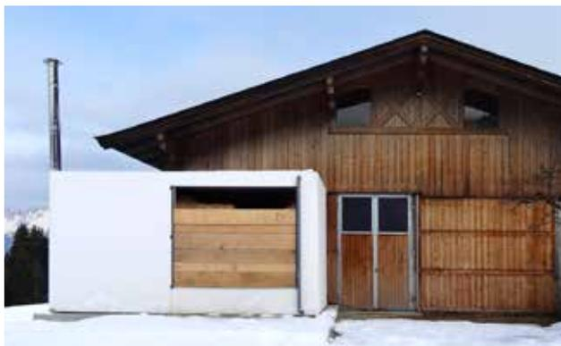
Module de chauffage à un étage 35 kW bois déchiqueté, exploitation agricole
