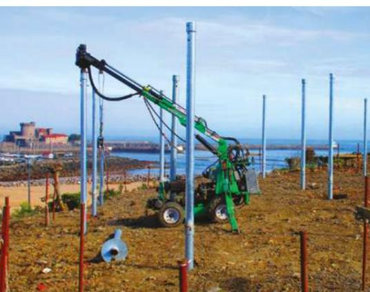
Techno Pieux a développé une gamme de machines entièrement dédiées à l'installation de pieux vissés. Ces machines permettent l'installation de pieux d'une capacité portante jusqu'à 225 kN par pieu. Elles sont très versatiles et peuvent accéder à presque tous les types d'environnement.
