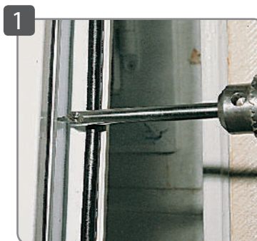
Percer la menuiserie \varnothing 8 mm
