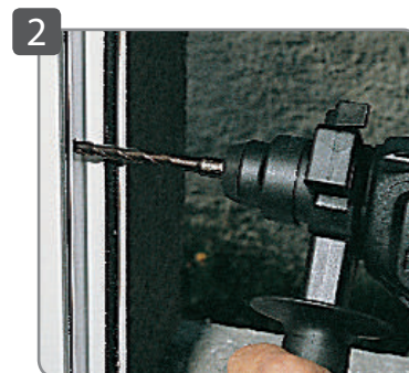
Percer un trou \varnothing 8 mm dans le mur à travers la menuiserie
