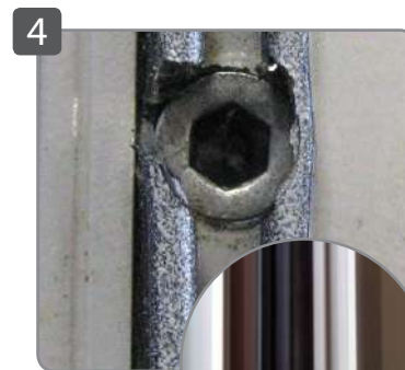
Le joint est mis en place : vis invisible !
