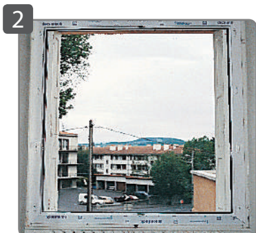
Positionner la menuiserie
