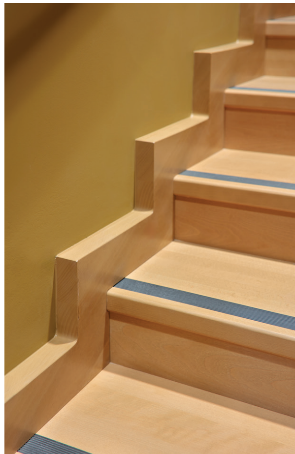
↑ Bandes anti-dérapantes : profil alu vissé dans la rainure avec bande en polymère
