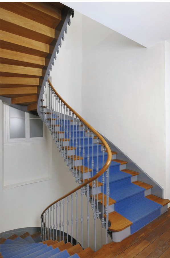
↑ Pose d'escaliers débillardés pour un établissement bancaire
