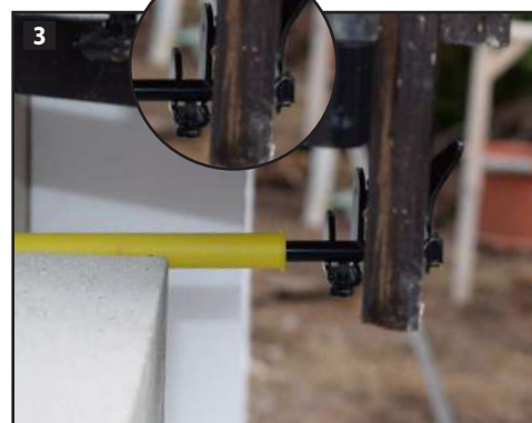
3 Installer la butée universelle : l'arrêt de volet ISO est mis en place !
