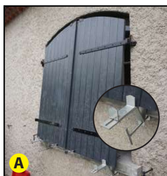
Déport du volet à l'aide du gabarit d'appui de fenêtre.
