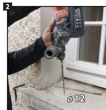
Percer Ø 12 au centre du repère.
