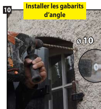
Percer Ø 10 et enfoncer la cheville blanche. Mallette : réf. A130110
