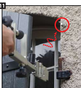
Insérer la vis papillon et positionner le gabarit d'angle.
