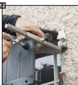
Ajuster la longueur selon l'épaisseur de l'isolant. Répéter l'opération de l'autre côté du volet.
