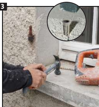
Enfoncer la cheville à l'aide d'un marteau.
