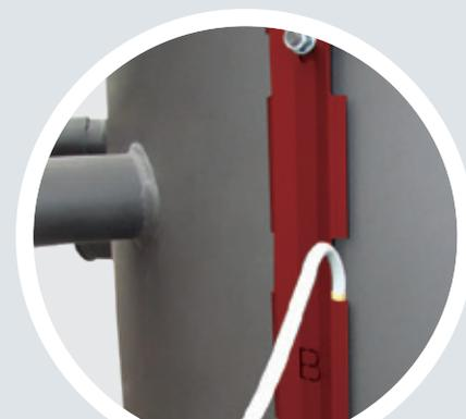
Le bon positionnement des sondes sur le bloc de jonction est primordial pour le fonctionnement optimal de l'installation!
