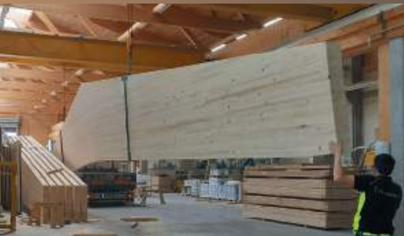
Charpente et structure
