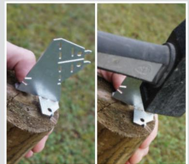
Positionner le connecteur au bord de la jambe de force. Frapper à l'aide d'un marteau sur les deux ailettes.
