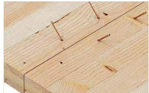
Liaison entre planchers CLT avec des vis ESCRFT
