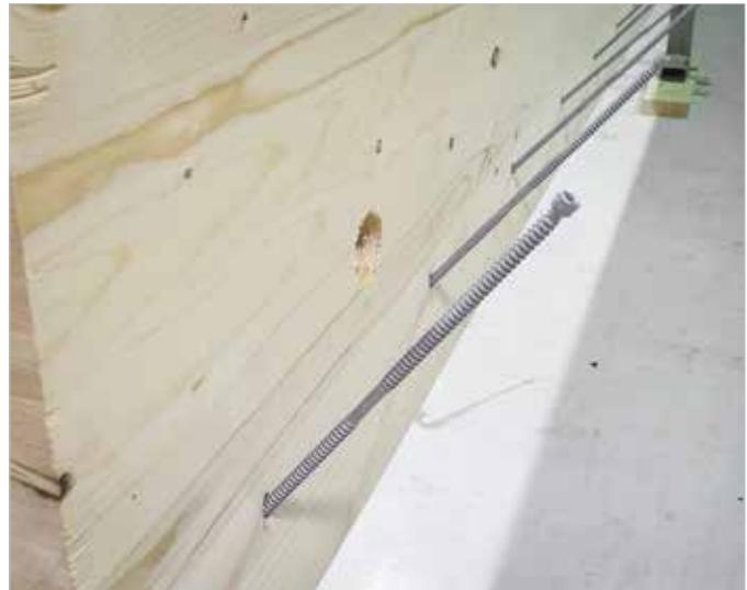
Vis SWD utilisées pour une liaison mur CLT sur plancher CLT
