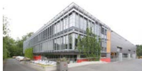
Le centre de développement et de commercialisation avec halles de montage de Müthing GmbH & Co. KG Soest.
