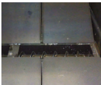
HSK-RA 200 X2 Commune de Queige (73) Réseau de chaleur communal Chaufferie avec 2 chaudières, trémie double de remplissage et 2 vis de répartition.
