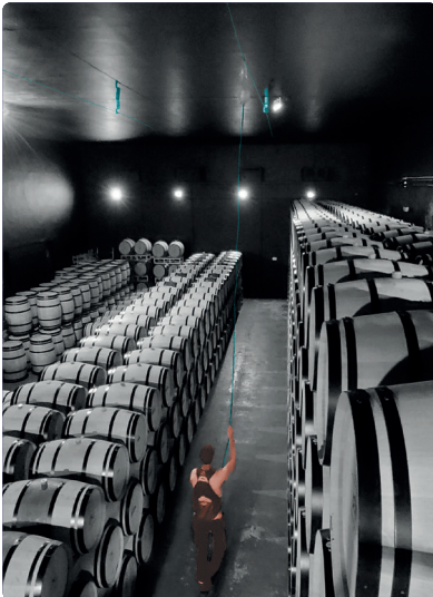
Contrôles périodiques de lignes de vie antichute au-dessus de tonneaux bois en milieu VITICOLE .
