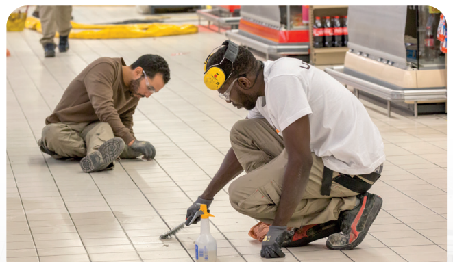
A l'issue des injections, les tubes sont sectionnés et les trous parfaitement rebouchés
