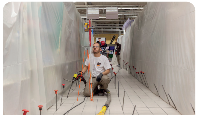
Avant la phase d'injection, les rayons sont protégés par des bâches
