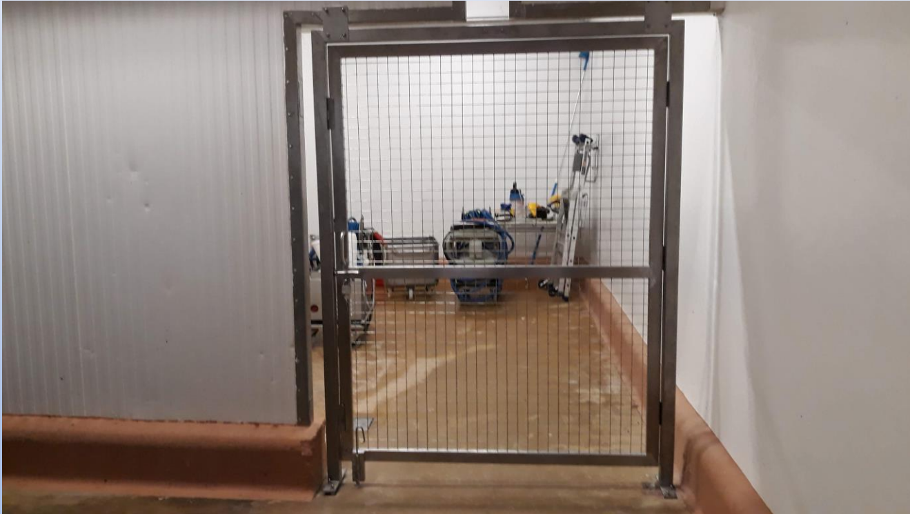
Fabrication et mise en place d'une porte inox.
