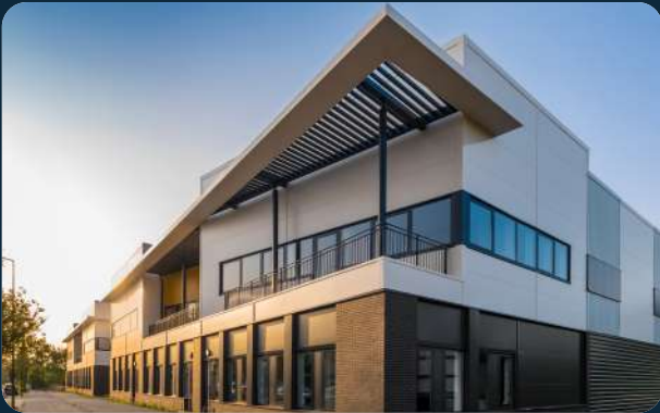
Parc Spirit Neuville Université • Neuville-sur-Oise (95) Cergy-Pontoise Aménagement - ORY Architecture
