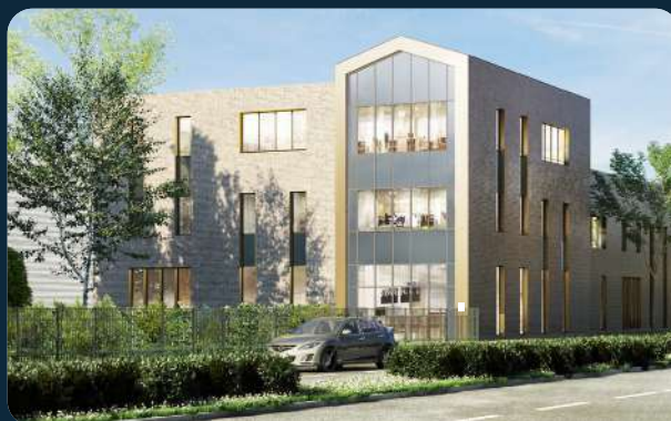
Parc Spirit de la Lainière • Wattrelos (59) Ville Renouvelée, Métropole Européenne de Lille ORY Architecture
