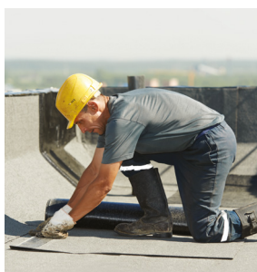
Isolation des toitures-terrasses
