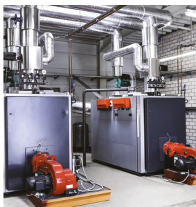
Remplacement de chaudière
