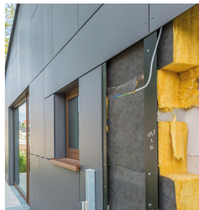
Isolation des murs par l'extérieur
