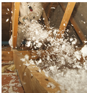
Isolation des combles
