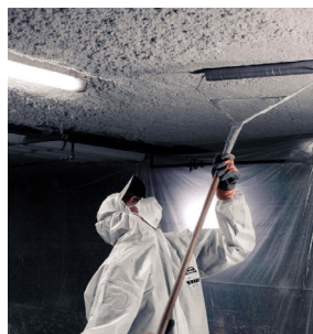
Isolation des planchers-bas
