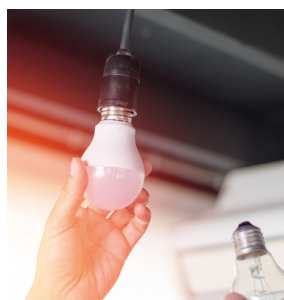
Installation de lampes à LED
