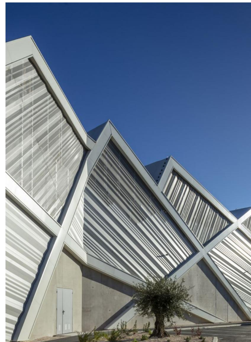
La toiture métallique à pans multiples dissymétriques se joue avec facétie des codes de l'architecture industrielle. Conçu pour gérer l'accueil, le tri et le conditionnement de 35 000 tonnes de déchets recyclables par an, l'ensemble paraît léger comme un origami d'aluminium.
