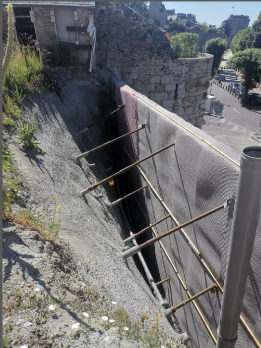
Voile de soutènement avec tirants CONFORTEMENT RAMPARTS VILLE DE DINAN (22)
