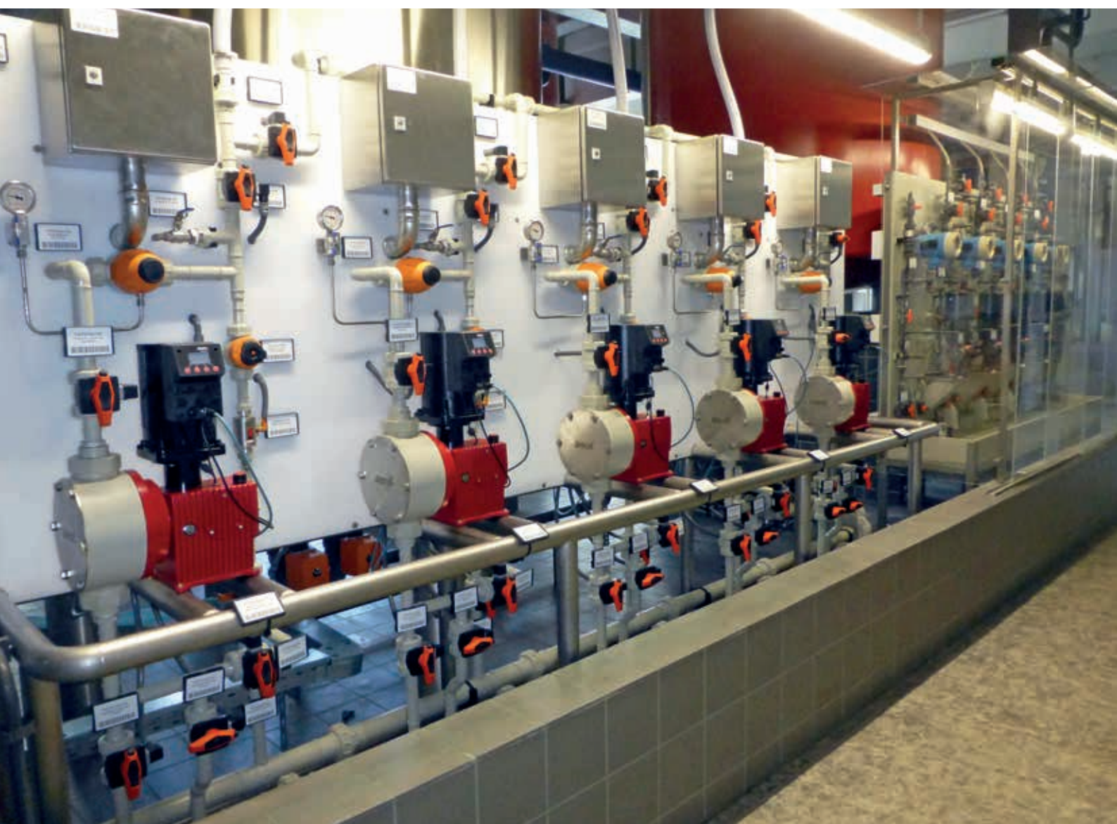
Installation de dosage pour agents floculants
