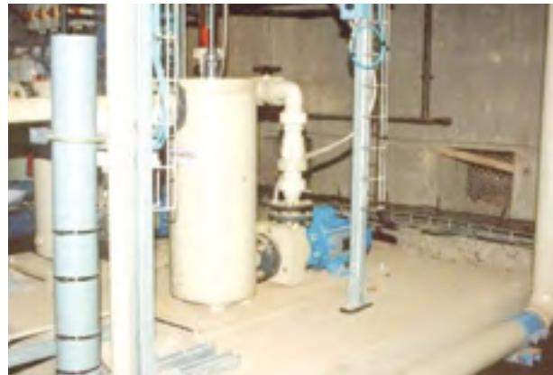
HMP avec réservoir d'amorçage
