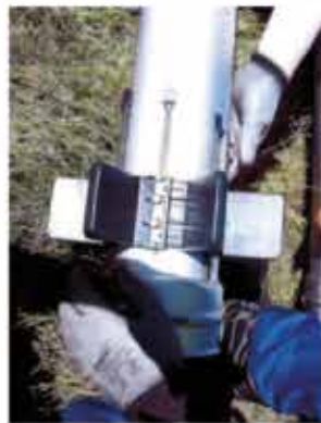
Centreur à segments munis d'un porte-sonde. PP usiné, assemblage par chevilles
