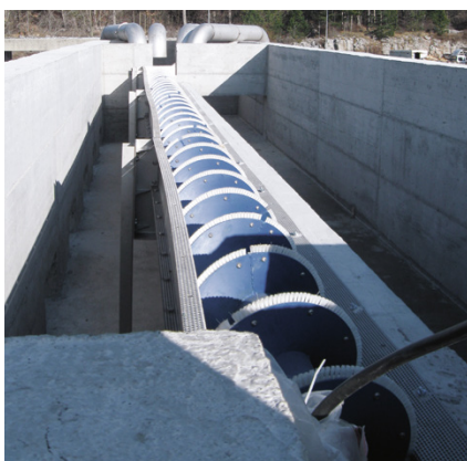
OVF 300 Dégrillage sur déversoir d'orage sur réseau unitaire
