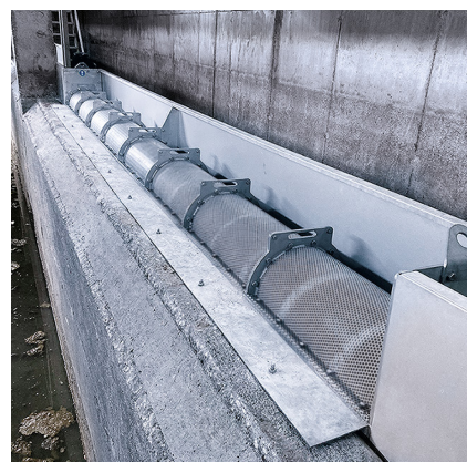
OVF-R 300 Dégrillage sur déversoir d'orage
