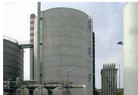
Filtre à ruissèlement dans l'industrie avec 16 m de profondeur de support Région de Bâle, Suisse
