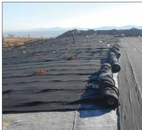
ISD d'Al Ghabawi (Jordanie) Produit : DRAINTUBE® FT Application : Drainage des eaux en couverture de casier Surface : 170 000 m 2
