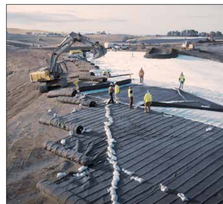
ISD Vancouver (Canada) Produit : DRAINTUBE® FT Application : Drainage des eaux en couverture de casier Surface : 250 000 m 2
