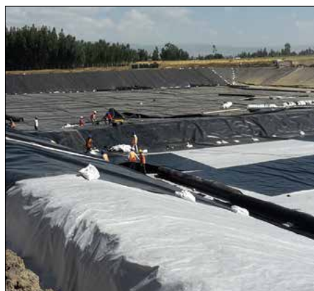
ISD de Sendafa (Éthiopie) Produit : DRAINTUBE® Conductive Application : Détection de fuites sous étanchéité Surface : 24 000 m 2
