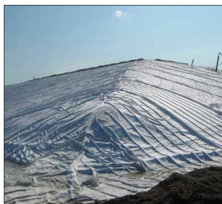
ISD Sainte-Sophie (Canada) Produit : DRAINTUBE® FT Application : Drainage des biogaz et eau de pluie en couverture de casier Surface : 500 000 m 2
