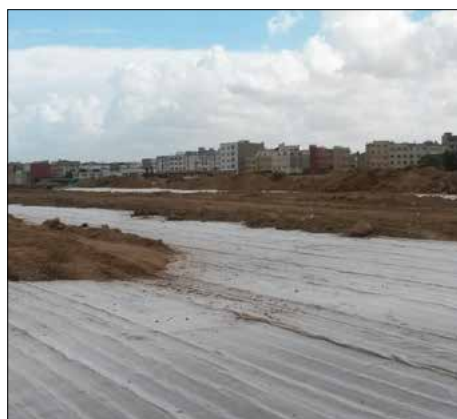
ISD Sidi Moumen (Maroc) Produit : DRAINTUBE® FTP Application : Drainage des eaux en couverture de casier Surface : 120 000 m 2
