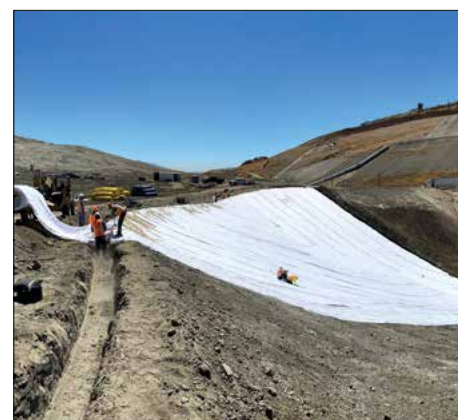
ISD Sunshine Canyon (Californie - USA) Produit : DRAINTUBE® FT Application : Collecte des biogaz en talus Surface : 19 000 m 2
