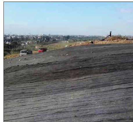
ISD Bucarest (Roumanie) Produit : DRAINTUBE® FT Application : Drainage des eaux en couverture de casier Surface : 302 500 m 2
