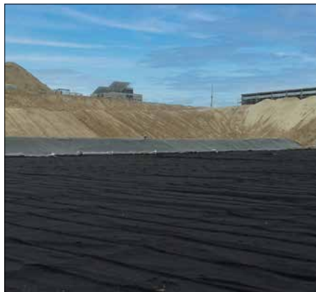
ISD Sofa - Al Fukhary (Gaza - Palestine) Produit : DRAINTUBE® ACB Application : Drainage en fond de casier Surface : 59 000 m 2
