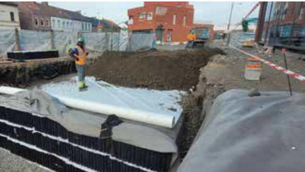
300M 3 - VIEUX CONDÉ Le ruissellement des eaux pluviales de la toiture et du parking a été pris en compte lors de la construction de ce nouveau supermarché LIDL. Ce bassin de rétention permet de stocker temporairement les eaux de pluie lors d'un orage, avant de les infiltrer progressivement.
