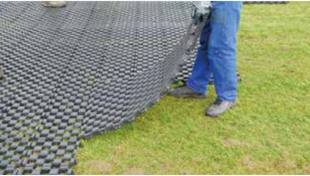
2 500M 2 - ANGLETERRE Lorsqu'un espace enherbé nécessite d'être circulé occasionnellement, la dalle RG035 renforce le gazon en surface. Elle permet notamment d'être carrossable, d'éviter le glissement et d'augmenter le confort de marche lorsqu'il est mouillé.
