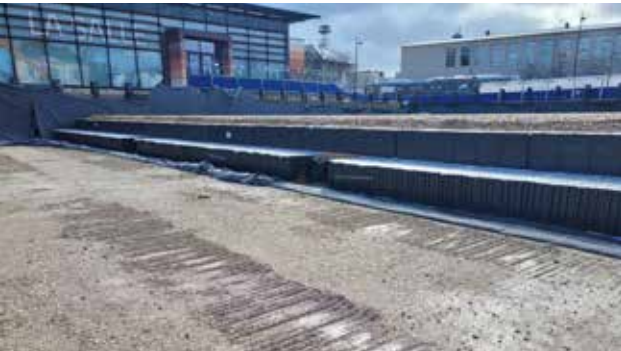
2 300M 3 - SAINT JEAN DE BRAYE Ayant déjà subi des inondations en 2018, la ville a choisi de réaménager son centre ville et de réaliser un bassin de stockage des eaux pluviales sous son esplanade avant de procéder à la végétalisation de la place pour le confort des habitants, un exemple d'intégration au paysage urbain.
