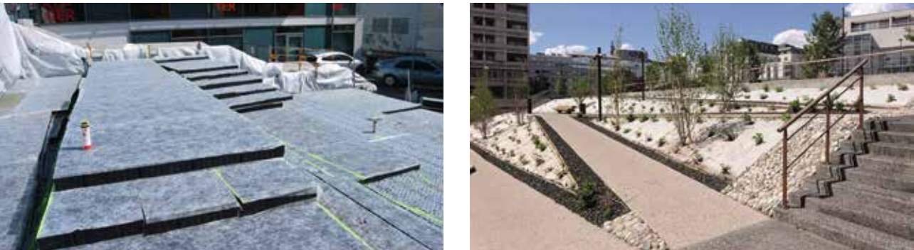
270M³ - ANNECY Pour l'aménagement de cet espace paysager complexe, les panneaux Nidaplast RA s'adaptent aux formes géométriques du chantier et ont permis de structurer différents niveaux, de créer des accès piétons et PMR tout en limitant les charges et poussées sur le bâtiment existant.
