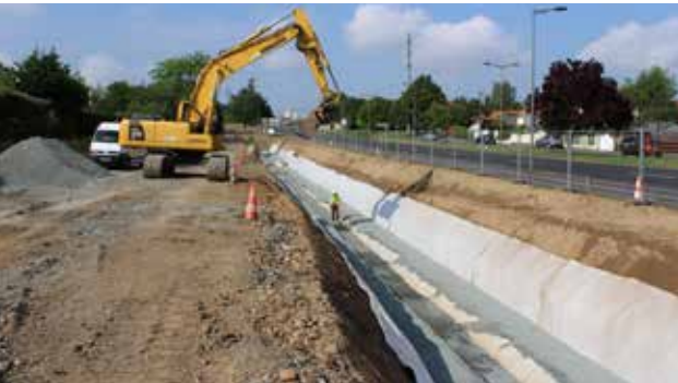
2 500M 3 - CHOLET Deux bassins enterrés, situés de part et d'autre d'un collecteur existant, ont été réalisés à proximité d'un axe routier très fréquenté pour répondre à la problématique d'inondation de ce secteur.
