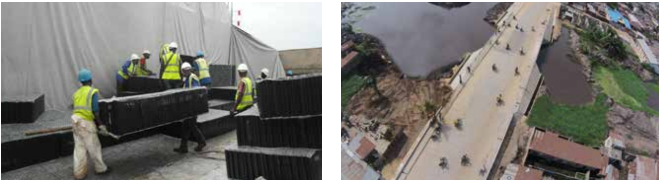
1 040M³ - COTONOU Pour la réalisation de ce pont, l'utilisation du remblai allégé permet de réduire les poussées latérales susceptibles d'entraîner des efforts sur les fondations.
