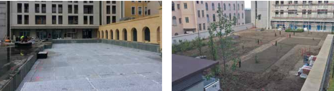
575M³ - LYON Pour aménager le jardin intérieur de l'hôtel Villa Maya, au-dessus du parking, une combinaison de blocs et de panneaux a permis d'atteindre les 1m20 de remblai nécessaire pour la réalisation de cet espace vert.
