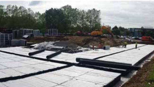
1 250M 3 - LABÈGE Pour réduire l'impact de cette nouvelle construction et limiter le ruissellement des eaux pluviales, un bassin enterré nidaflow permet de stocker près de 1200 m 3 d'eau. Il évite ainsi la surcharge des réseaux lors de fortes pluies et limite les risques d'inondation.
