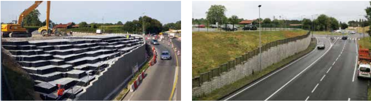
2 400M³ - TARNOS Les blocs Nidaplast RA, posés contre ce mur de soutènement, permettent de limiter les poussées latérales et rendent possible la construction de ce parking de tramway situé au-dessus d'une route.
