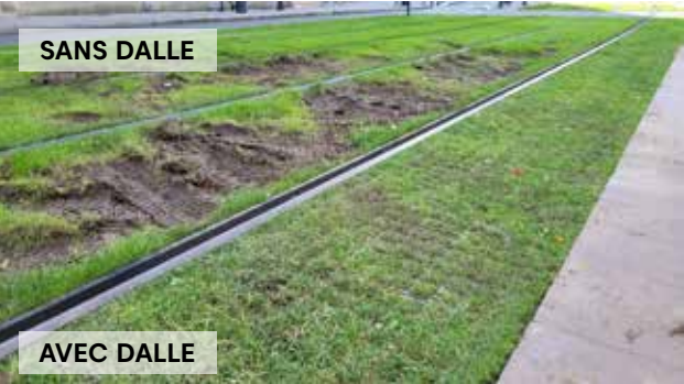
2 000M 2 - VALENCIENNES Les zones végétalisées de la voie du tramway peuvent être abîmées par des véhicules circulant de manière occasionnelle. Les dalles nidagrass permettent de renforcer ces espaces et de les consolider, notamment en période humide en évitant la création d'ornières et de boue.
