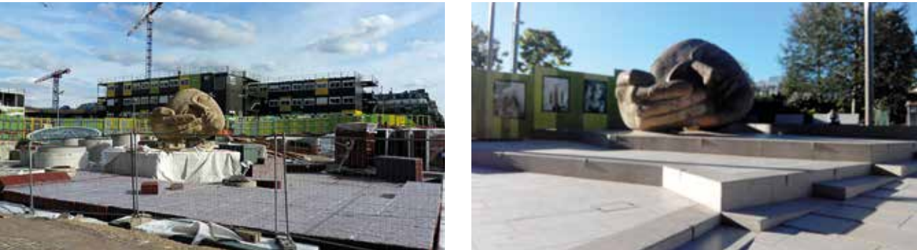
6000M³ - PARIS, JARDIN NELSON MANDELA Pour la réalisation de cet aménagement, située au-dessus du métro du forum des halles, l'utilisation des blocs Nidaplast RA a permis de réaliser des aménagements paysagers végétalisés, le «poumon vert» des halles.
