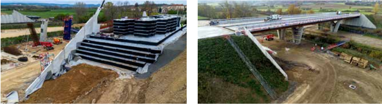
6 000M³ - BRIOUDE Ce viaduc a été réalisé pour permettre le franchissement d'une voie ferrée, de la Leuge et d'une route départementale. Afin de stabiliser les tassements et de limiter les poussées latérales sur l'ouvrage, les blocs alvéolaires Nidaplast RA sur 10 mètres de hauteur, remplacent le remblai classique.
