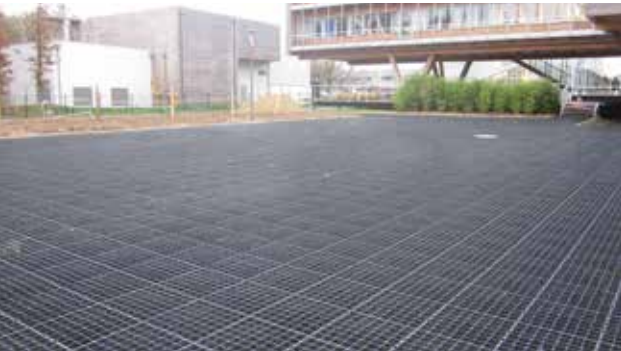
750M 2 - NANTES Pour rester cohérent avec son univers boisé, cette université a souhaité réaménager son parking avec 750m 2 de Nidagrass. L'épaisseur des parois épaisses assure une résistance importante de la plaque pour cet espace de stationnement VL.
