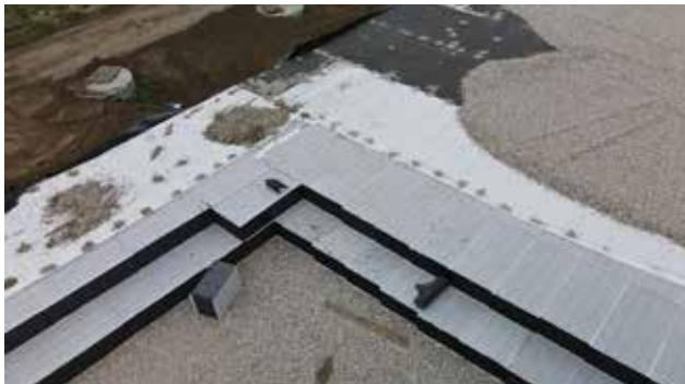
9100M 3 - PRUSZCZ GDANSKI En zone péri-urbaine, deux couches de blocs alvéolaires nidadplast ont été installées pour réaliser certainement l'un des plus grands bassins de rétention des eaux pluviales dans le monde, en 2023.
