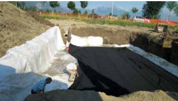
180M 3 - LA GARDE Un bassin étanche situé aux abords de la concession Mercedes de La Garde, dans le Var permet de stocker les eaux de pluie issues du ruissellement.
