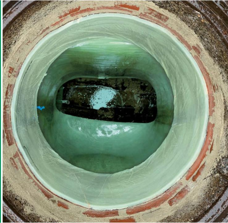
Avec le **BB<sup>2.5</sup> VERTICAL**, nous disposons pour la première fois d'une gaine de regard qui peut être polymérisée de manière fiable avec la technologie UV et LED. Fiable et efficient.
