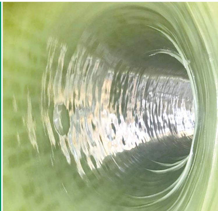
La gaine **BB<sup>2.5</sup>** est proposée **pour tous les diamètres nominaux**. La disposition unique des mâts en fibre de verre utilisés confère au matériau une résistance élevée. Ainsi, même pour les exigences statiques les plus strictes, vous bénéficiez d'un liner performant, à la fois robuste et fin – pour une installation facile et durable.
