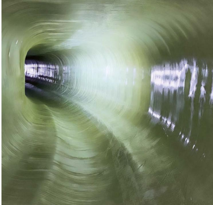
La gaine pour les géométries spéciales, les profils spéciaux, les coudes et les sauts dimensionnels.
