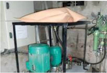
Protection de l'huile d'un moteur de porte d'écluse Hydraulique
