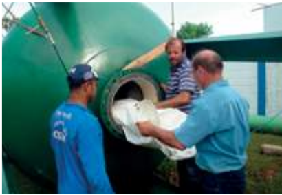
Amortir les ondes de choc sur un réseau / Anti-bélier Industrie
