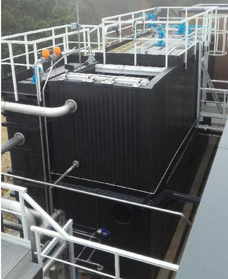
Cuve de traitement d'eau potable à compartiments, réalisation en parois alvéolaires
