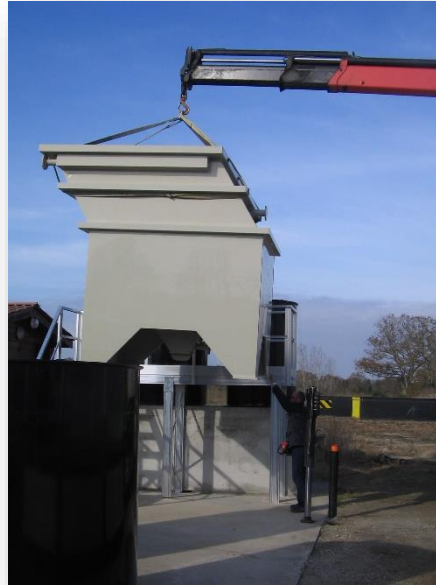
En PPH – Décanteur Lamellaire avec lamelles en PP – Double surverse en sortie (réglage du niveau par peigne)
