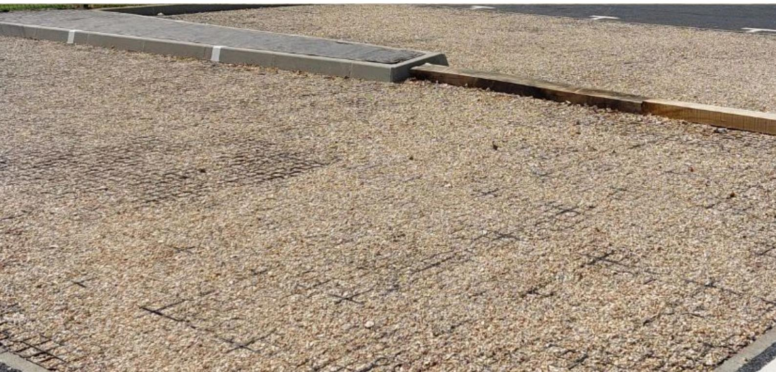
Dalles alvéolaires pour l'infiltration des Eaux Pluviales
