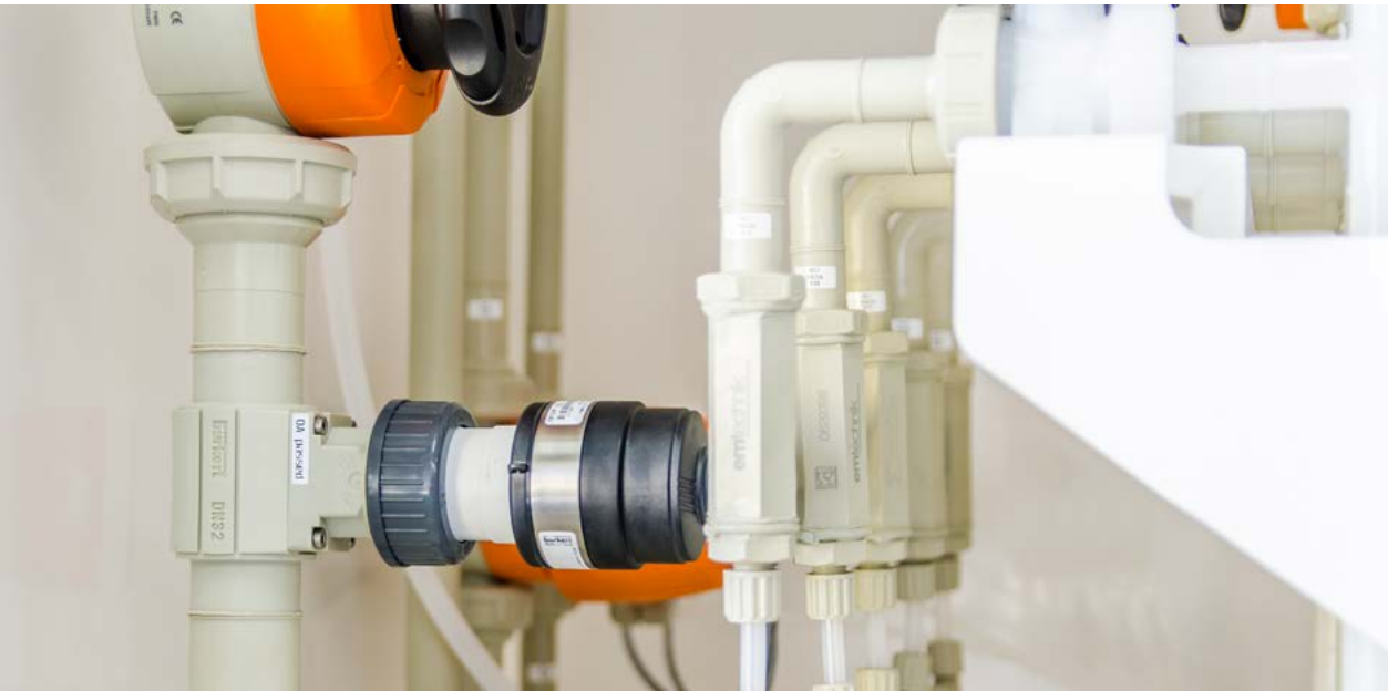
Conductivimètre pour la surveillance de la qualité de l'eau ultrapure (source : RENA Technologies GmbH)
