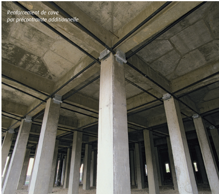
Renforcement de château d'eau par cerces de précontrainte additionnelle
