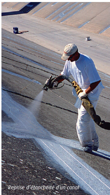
Application de revêtement d'étanchéité
