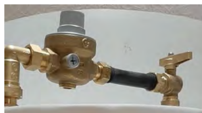
Montage pour compteur DN15 lg 110 mm + Réduc lg 76 mm
