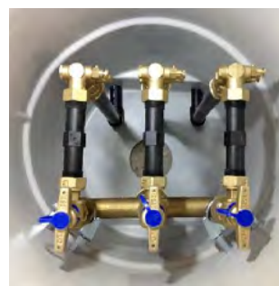
ISO CYL 430 V. PEHD 3 compteurs DN15 lg 110
