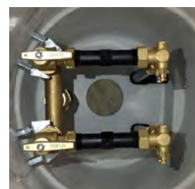
ISO CYL 430 V. PEHD 2 compteurs DN15 lg 170
