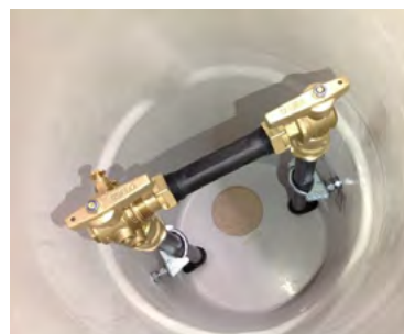
Montage pour compteur DN15 lg 110 mm
