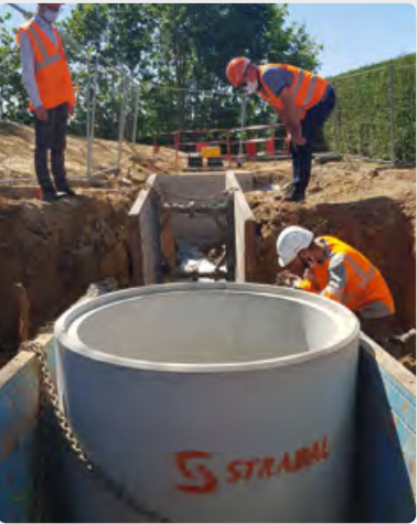
DDSELECT™ en amont d'un puisard d'infiltration à Saint-Quentin (02)
