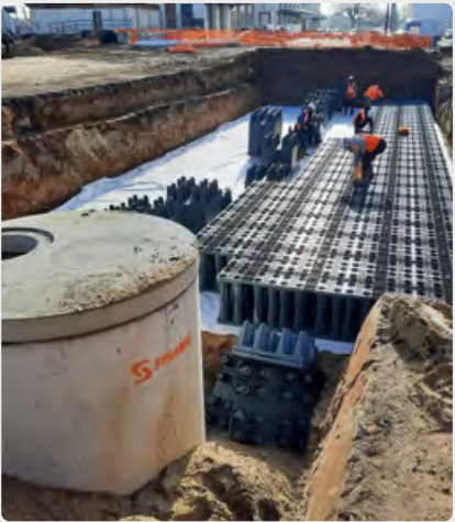
DDSELECT™ en amont d'une SAUL d'infiltration à Marmande (47)
