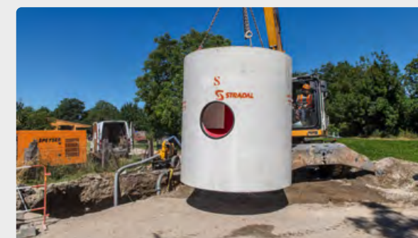
Traitement des eaux de ruissellement de la commune de Plobsheim (67) avant rejet dans le milieu naturel
