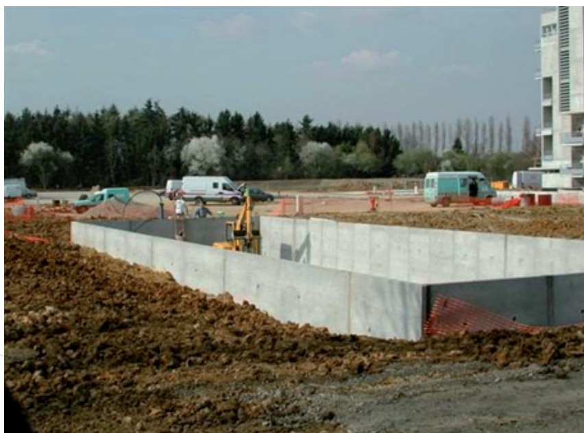
Figure 22 – Bassin en murs préfabriqués assemblés [Chapsol]
