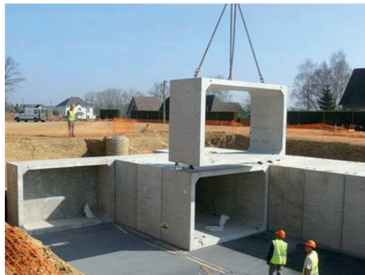
Figure 19 – Bassins de rétention en cadres préfabriqués [Chapsol Ecobassin]
