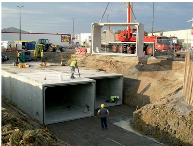
Figure 31 – Pose de cadres préfabriqués en parallèle [Chapsol Ecobassin]
