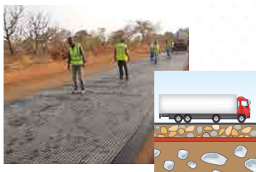
Renforcement de chaussées
