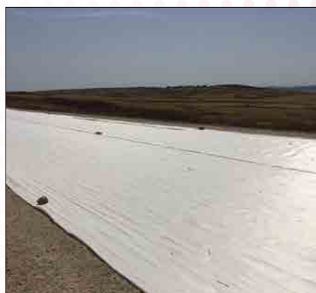
Autoroute A3 / Oued Zarga - Bou Salem (Tunisie) Produit : GEOTER® FN Application : Sécurisation de cavités
