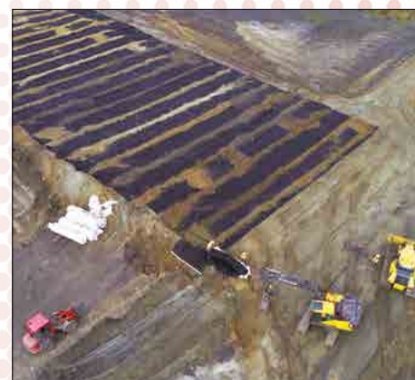
Canal de Condé Pommeroeul (59) Produit : SONTUBE® FTF Application : Drainage sous digue
