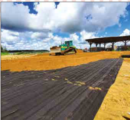
Port maritime de Cayenne (Guyane) Produit : SOMETUBE® FTF Application : Drainage sur drains verticaux
