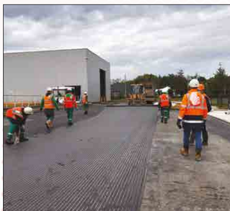
Plateforme logistique Vert-Saint-Denis (77) Produit : NOTEX® GLASS C Application : Renforcement bitumineux
