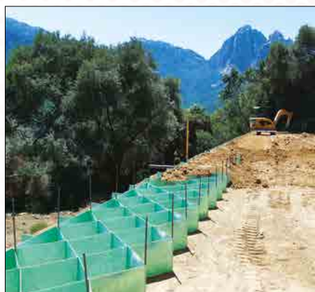
OTA - Corse (2A) Produit : M3S® Application : Mur de soutènement
