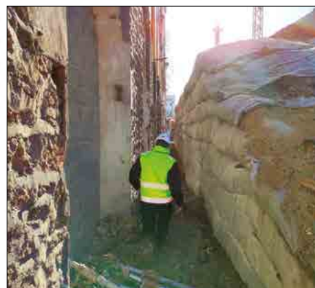
Village des athlètes Saint Denis (93) Produit : NOTEX® GX Application : Remblai renforcé
