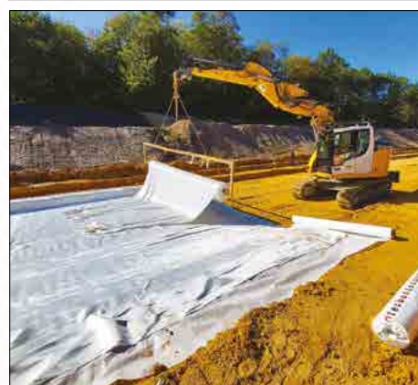
Déviations du Taillan-Médoc (33) Produit : NOTEX® GX Application : Renforcement risque cavités
