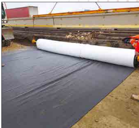
Contournement Nord-Est de Metz (59) Produit : GEOTER® FPET Application : Remblais sur sols compressibles
