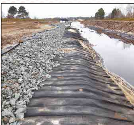
Déviations du Taillan-Médoc (33) Produit : SOMETUBE® FTF Application : Drainage sous remblai
