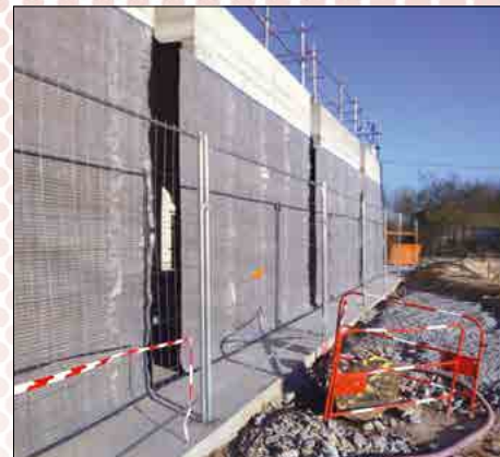
Pontrail de Montaigne (85) Produit : ALVEODRAIN® F Application : Drainage vertical en ouvrage d'art
