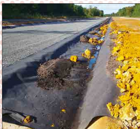
Déviations du Taillan-Médoc (33) Produit : STABILINER® GTX Application : Étanchéité des fossés
