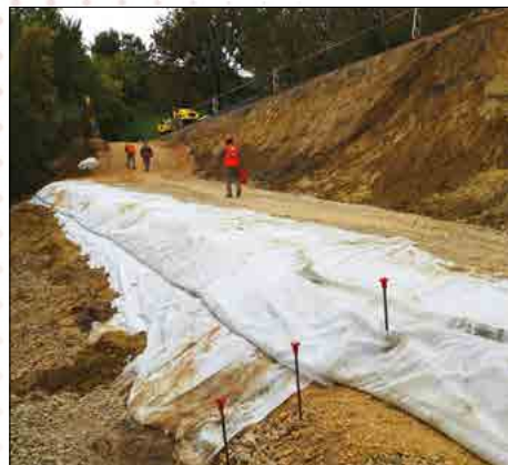
Glissement de la RD959 L'Honor de Cos (82) Produit : NOTEX® GX Application : Remblai renforcé
