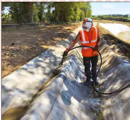
Déviations de Ferrière en Bray (76) Produit : CIMTEX® Application : Imperméabilisation et étanchéité des fossés et cunettes
