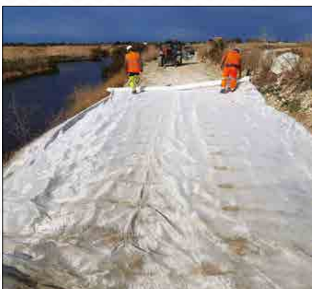
Digue de La Couarde Sur Mer (17) Produit : NOTEX® GX Application : Renforcement sur sols compressibles
