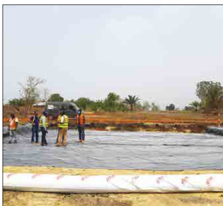
Route de Toffo Lalo (Bénin) Produit : GEOTER® F HCR & PROTECTERRE® PF Application : Renforcement de chaussée
