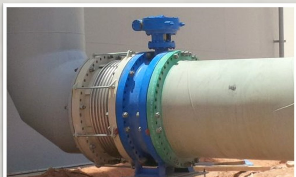
Compensateur métallique avec tirants
