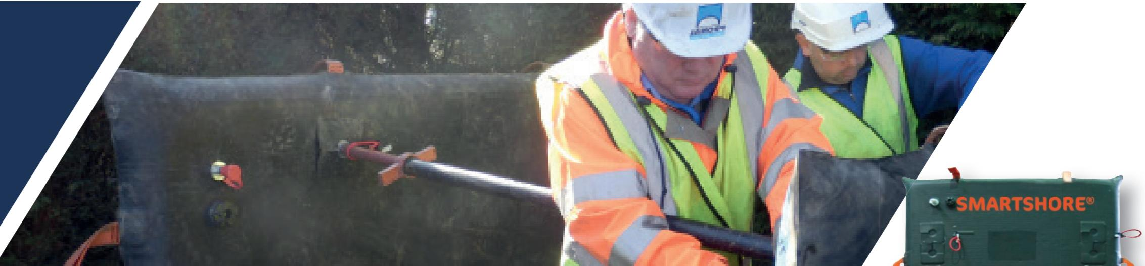
Lors des travaux de fouille ou d'excavation sur chantier, il est indispensable d'assurer la sécurité des opérateurs. Ces travaux générant des risques d'éboulement et d'ensevelissement, l'article R4534-24 du Code du Travail impose aux tranchées de plus de 1,30m de profondeur et dont les parois sont verticales, d'être blindées ou étayées.
