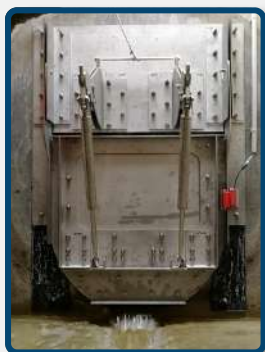
VANNE HYDRODYNAMIQUE AUTONOME DE RETENTION (VHA RET)
