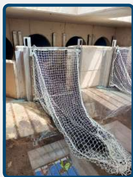
PIÈGE À MACRO-DÉCHETS À SURVERSE (PMD À SURVERSE)
