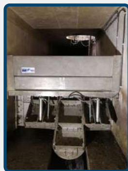
VANNE HYDRODYNAMIQUE PILOTÉE (VH PILOT)
