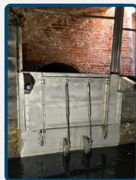
SEUIL HYDRODYNAMIQUE BASCULANT (SH B)
