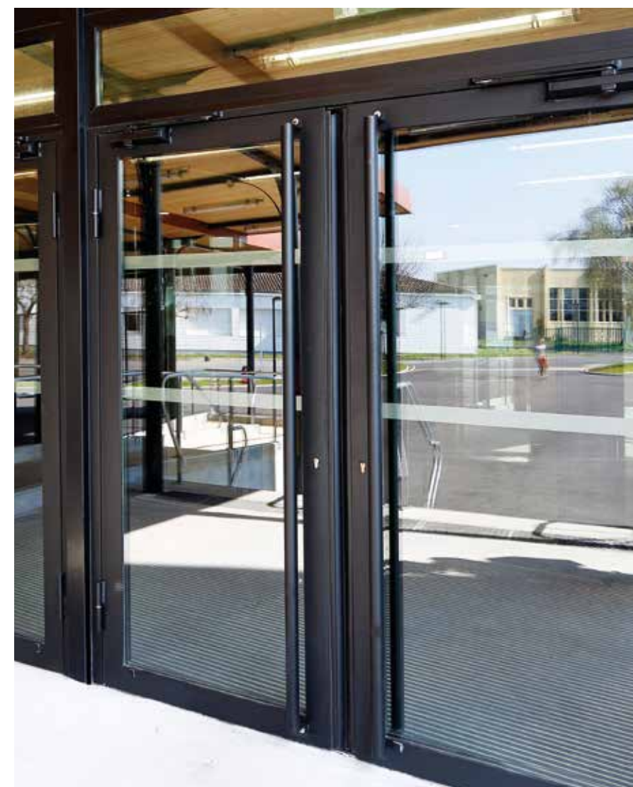
Lycée Jean Monnet, Blanquefort (33) Architecte : Bruno Bassi - Entreprise : Richard SA - Photo : Patrick Loubet
