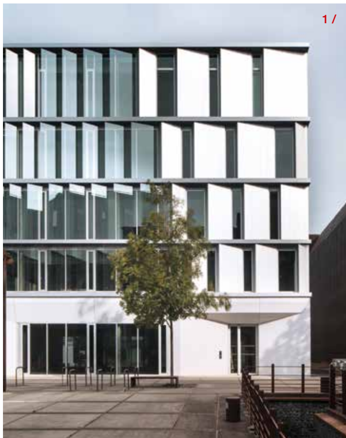
1 / Lucio, Lille - Barbarito Bancel - Architectes : STM Groupe Roger Delattre Photo : Alessandra Chemollo 2 / Tour Henninger, Francfort Architecte Meixner Schlüter Wendt - Iflt Institut für Fassadentechnik Francfort 3 / Palazzo Meridia, Nice Architecture Studio - Difral - Nexity Ywood - Photo Hervé Fabre
