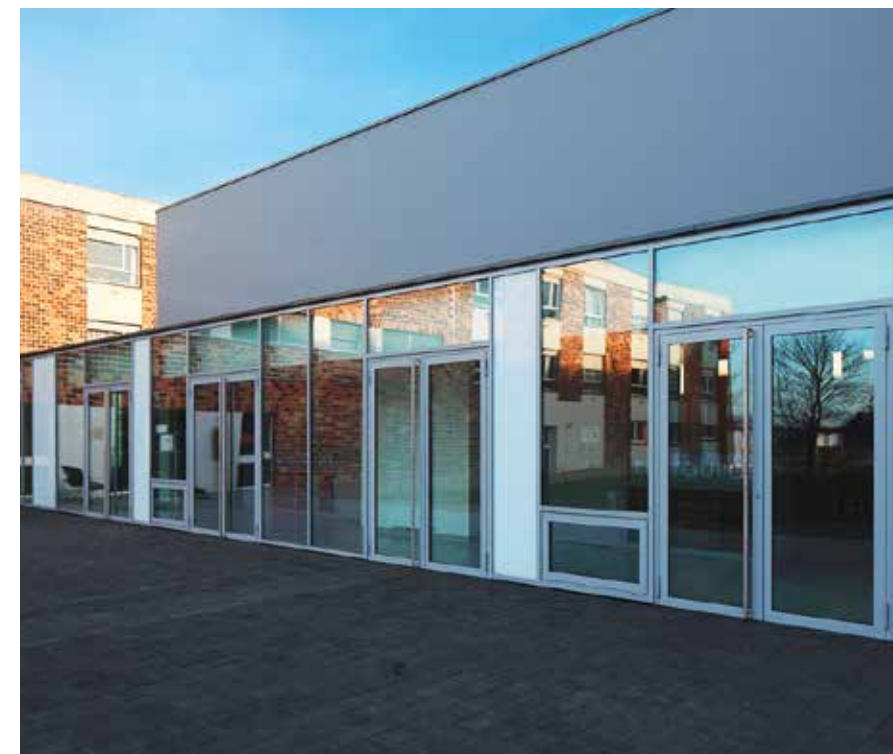
Maison de retraite départementale de Laon (02) - Lazo & Mure Architectes (75) Entreprise : E2MK, Laon (02) - Photo : Patrick Loubet
