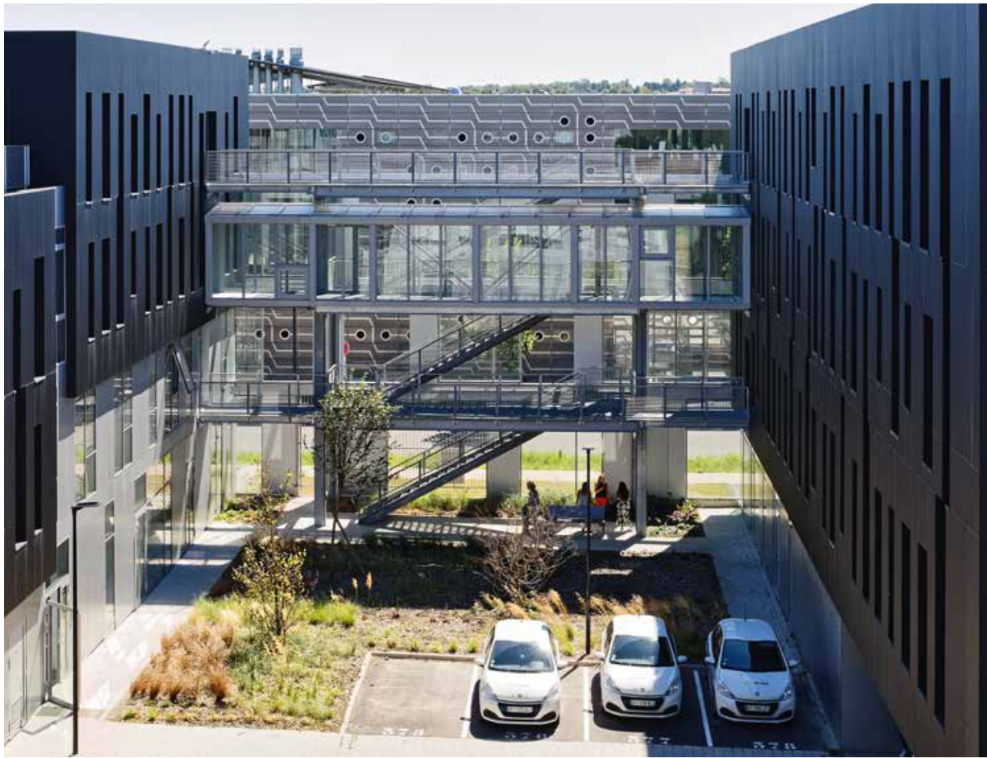
Helios (59) - Architecte : WE BAU (59) - Entreprise : STM, Groupe Roger Delattre (59) - Photo : Franck Deletang
