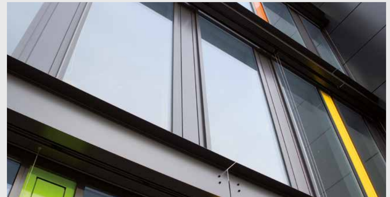
Rathauspassagen, Solingen - EPA Planungsgruppe GmbH Architekten + Stadtplaner Cannstatter Carree Fabricant : Medicke Metallbau GMBH - Photo : DR WICONA
