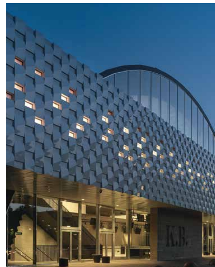
KB Hallen, Kopenhague, Danemark Architecte : Christensen & Co. Architects - Photos : Erik Wik
