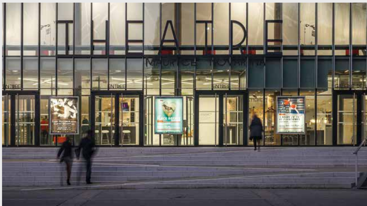
Théâtre Maurice Novarina, ville de Thonon-les-Bains Wimm Architectes (architecte mandataire) (38) Silo Architectes - Carine Bonnot (architecte associé) (38) Entreprise : Steelglass, Neyron (01) - Photo : Gilles Bertrand
