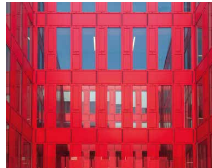
Campus Jourdan, Paris 14 e (75) - Architecte TVAA (75) Entreprises : Blanchet Métallerie du Forez (42) et Gauthier (63) Photo : Géraldine Bruneel
