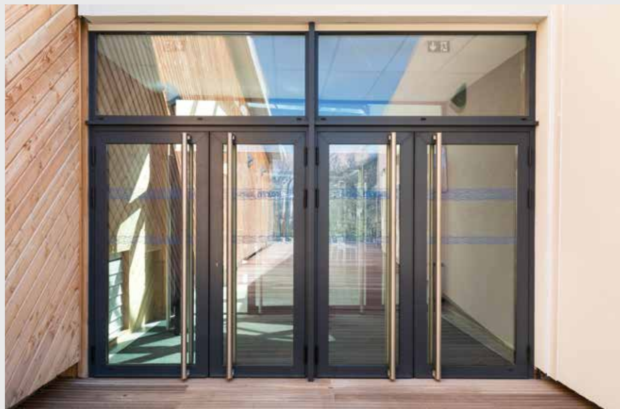
Complexe thermal de Roquebillière, Berthemont-les-Bains (06) - Coste Architecture, architecte mandataire, Montpellier (34) - Paris (75) Chevalier-Triquenod, architectes associés, Nice (06) - Entreprise : DIFRAL, Carros (06) - Photo : Hervé Fabre
