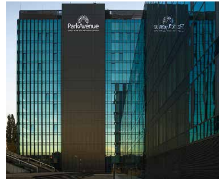
Park Avenue, Pologne - Architecte : JSK Architeckc - Entreprise : WARBUD - Photo : Leszek Ogrodnik
