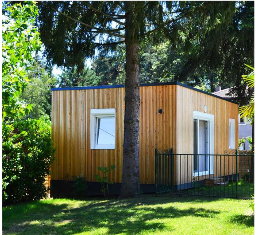
Ossature bois et bardage Mélèze
