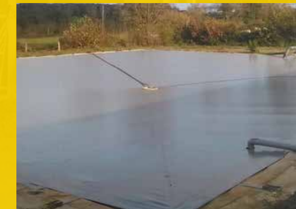
Couverture de lagune : flottante ou fixée
