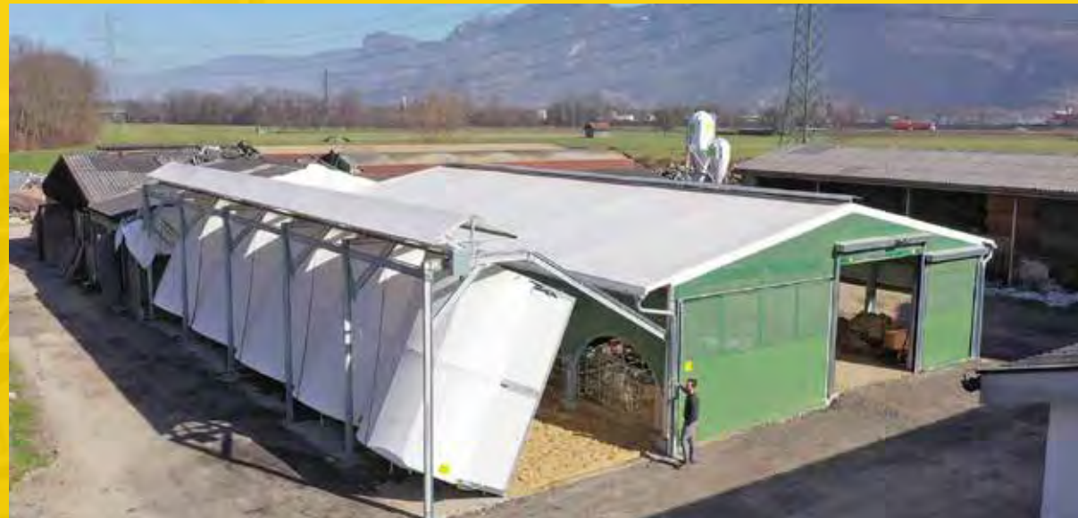
Gain de temps grâce au dispositif de basculement
