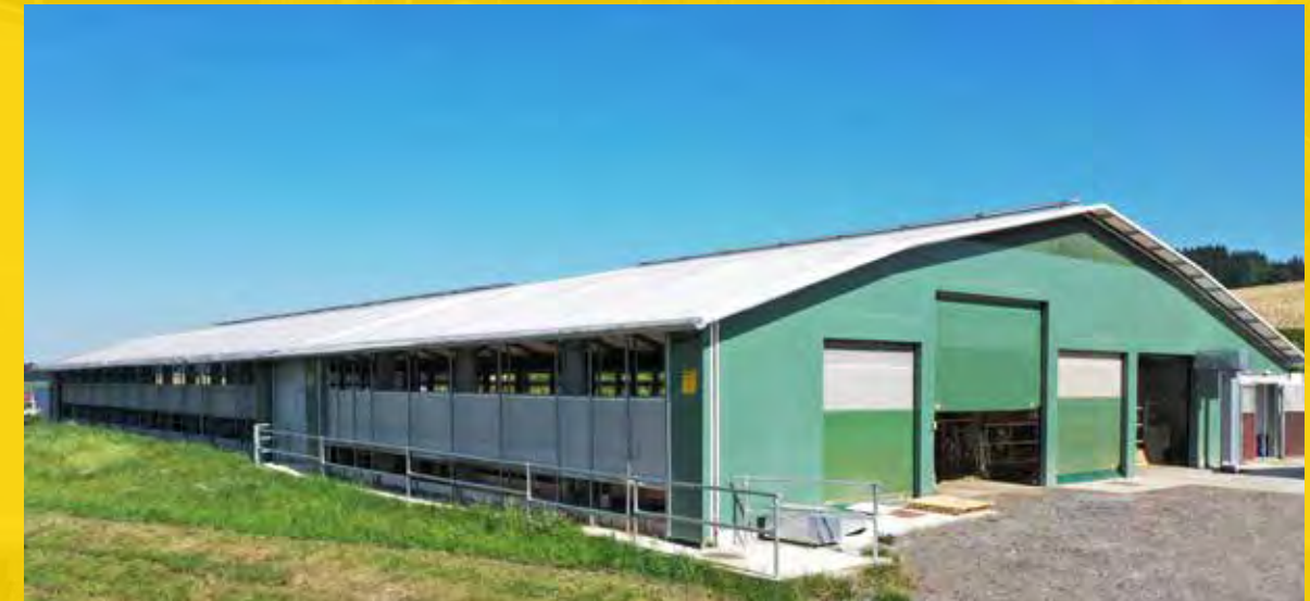
Étable de bien-être pour les vaches laitières avec système 4 et portes textiles
