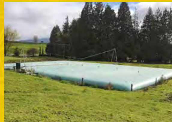
Réservoir d'eaux usées
