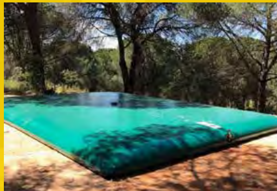
Réservoir d'eau de pluie
