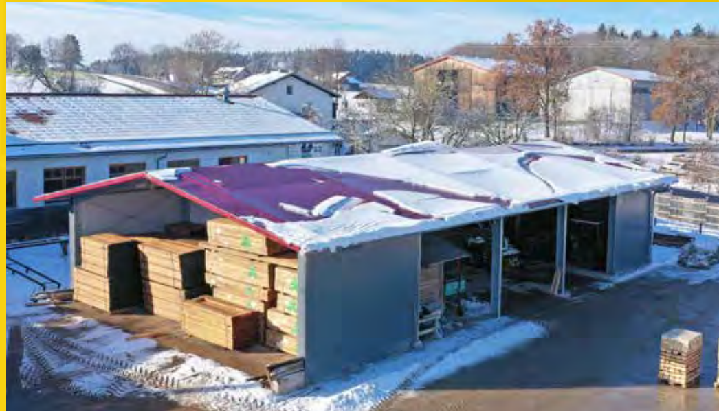
HALL DE MACHINES AVEC AUVENT
