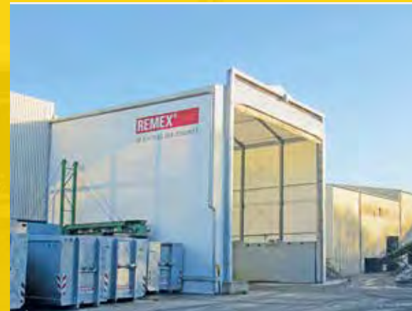
Hall pour le secteur du recyclage
