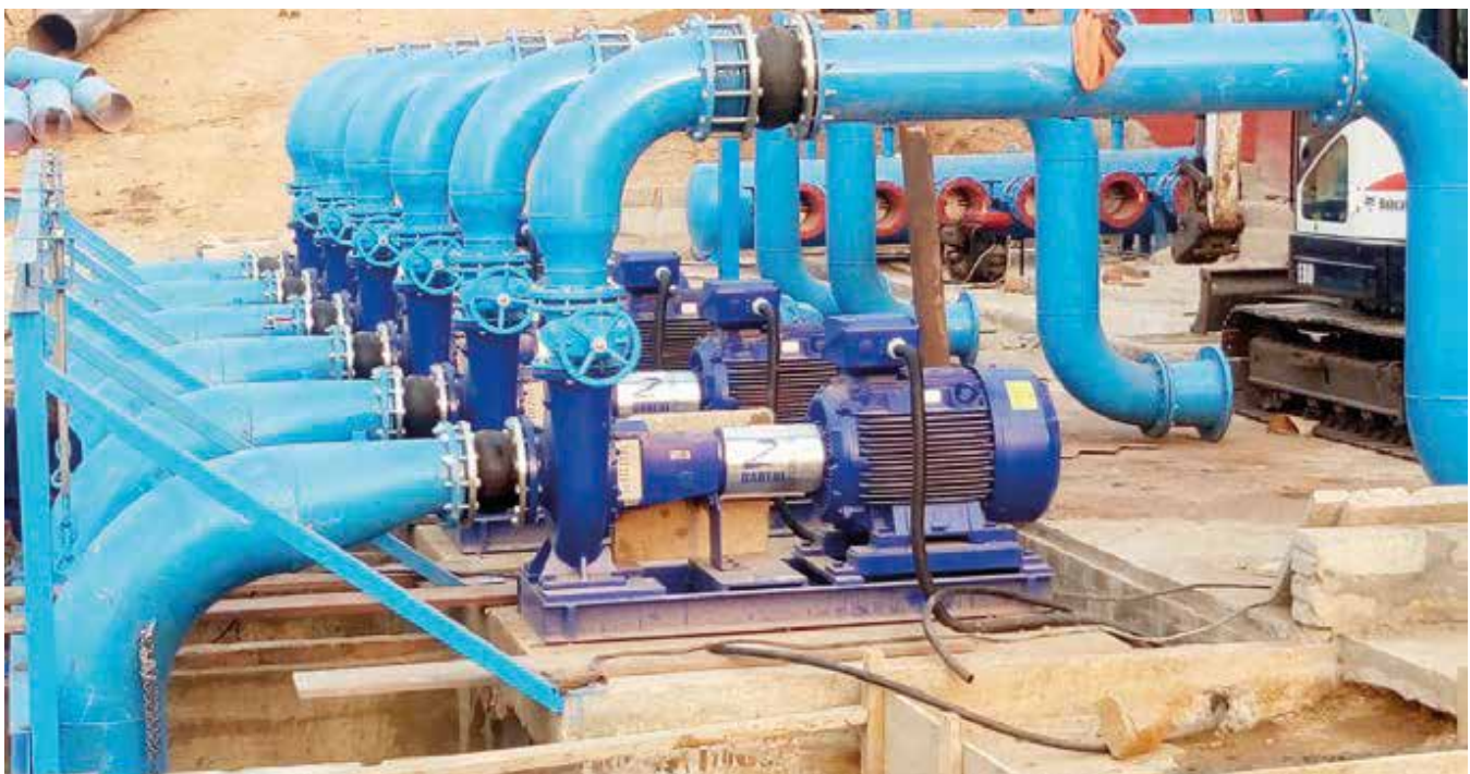
Pumping station with electric pumps being installed Station de pompage avec électropompes en cours de montage
