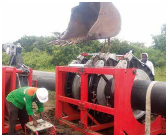
Polyethylene pipe butt welding Soudage bout à bout de tuyaux en PE
