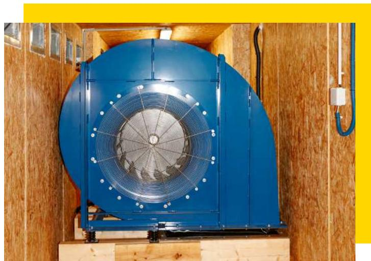
Tous nos ventilateurs sont installés sur des silencieux blocs afin d'absorber les vibrations lors du fonctionnement garantissant ainsi une plus longue durée de vie.
