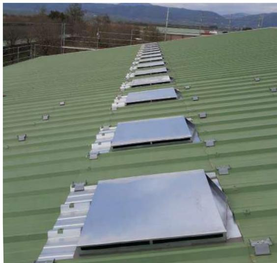
La circulation de l'air est réalisée grâce au système Fix&Dry® développé par BASE (cheminées d'aspiration d'air). Les panneaux reposent sur un système de rails sur bac acier fixé sur les pannes de la charpente.
