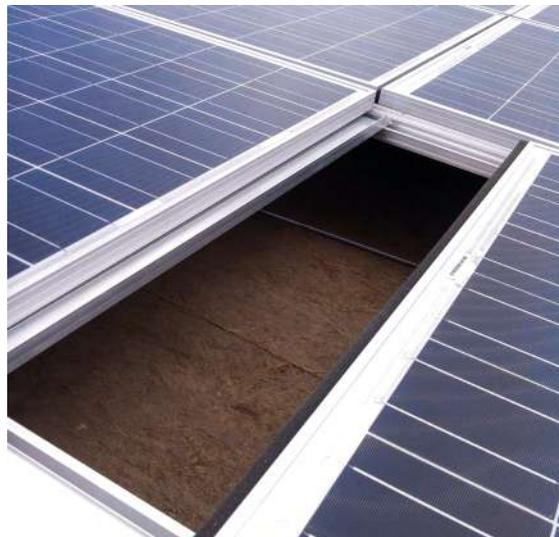
La circulation de l'air se fait entre les panneaux et une double peau sous toiture. Les panneaux et la fixation assurent la couverture du bâtiment.
