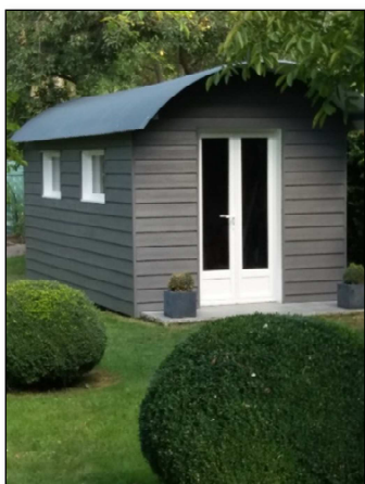
Toitures roulottes, abris de jardin, etc....
