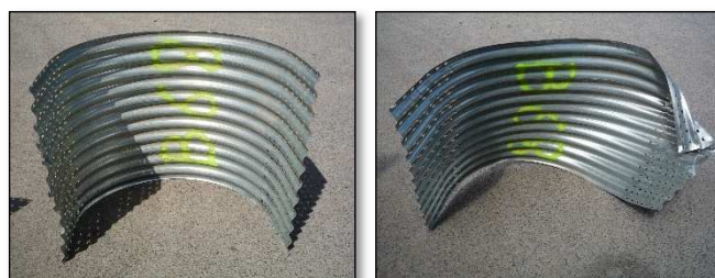
Redressage de gaines de ventilation
