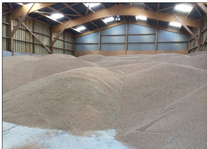
Ventilation céréales avec caniveaux
