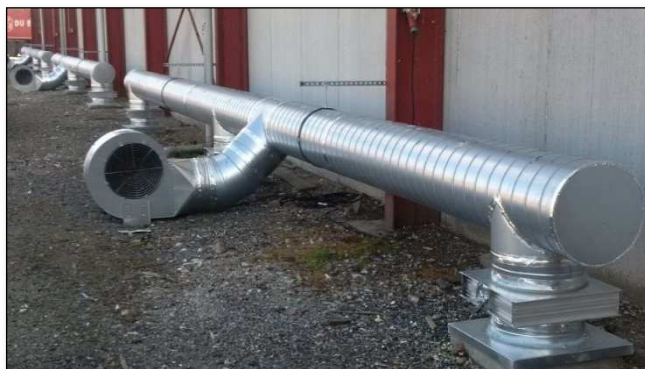
Collecteurs d'air avec ventilateur centrifuge
