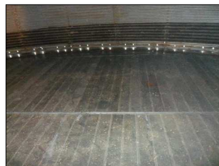
Ventilation par plancher perforé
