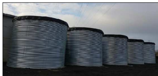
Réserves d'eau horticulture
