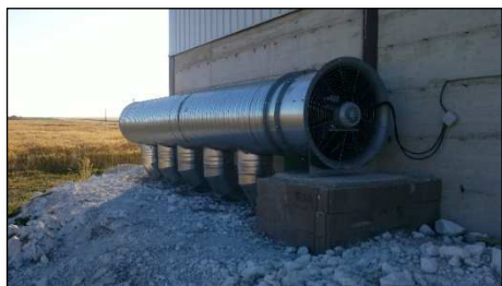
Collecteurs d'air avec ventilateur axial
