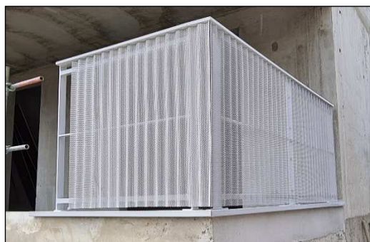
Garde-corps en tôles ondulées perforées
