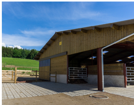
Cours de ferme et aires de stockage
